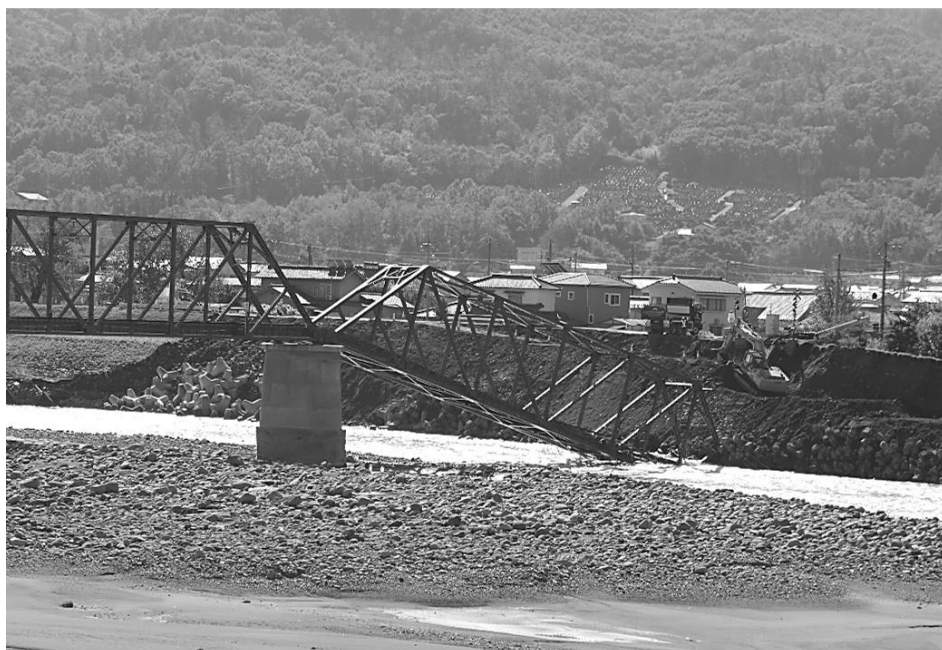
写真2 2019年台風19号で被災した上田電鉄別所線千曲川橋梁の様子 (2019年10月28日筆者撮影)
